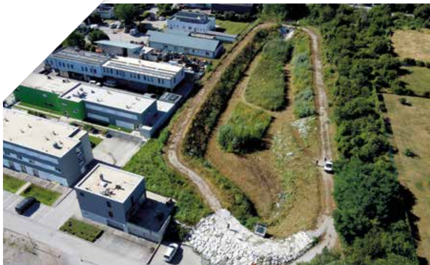
Drohnenaufnahme Hochwasserrückhaltebecken an der Kammeringstraße
