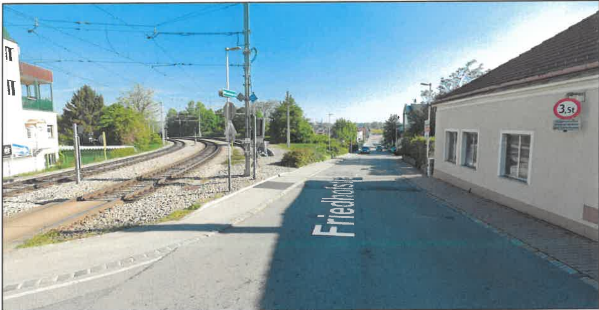
Abbildung: Ansicht des Änderungsbereiches (linker Fahrbahnrand und Gehsteig), in Blickrichtung Norden, mit der angrenzenden Trasse der „Badner Bahn“ und dem beginnenden Böschungsbereich (Bildmitte); Quelle: „google-street-view“ – Aufnahmedatum April 2024
