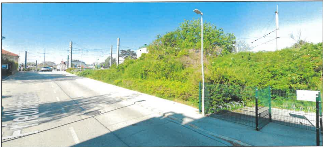
Abbildung: Ansicht des Änderungsbereiches (rechter Fahrbahnrand und Gehsteig) mit Blickrichtung Süden mit der dahinterliegenden Trasse der „Badner Bahn“ und dem Böschungsbereich zur Trasse; Quelle: „google-street-view“ – Aufnahmedatum April 2024
